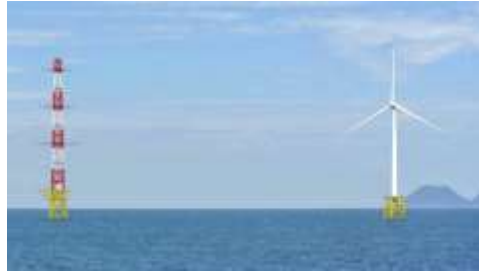
Hibikinada 2013 JSW 2MW
